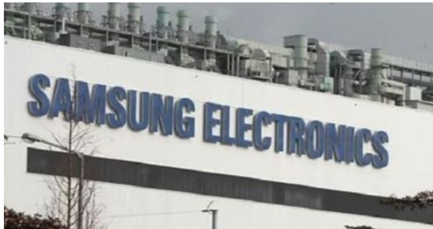
三星电子芯片工厂“9·4” CO 2 灭火系统泄漏事故
