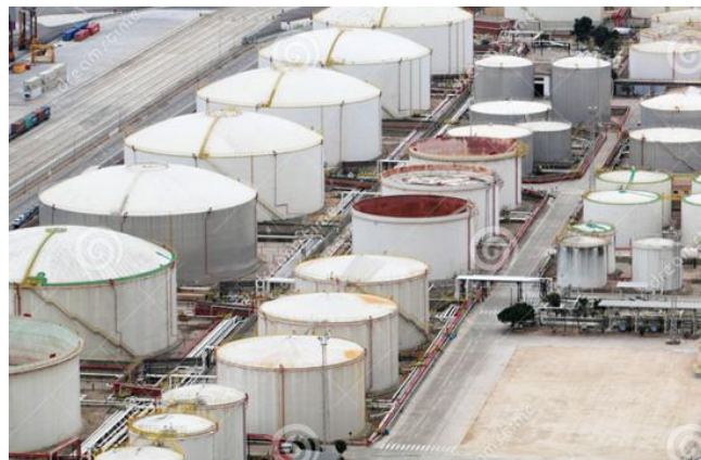
罐型不同的储罐区
