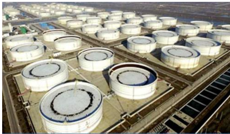
罐型相同的储罐区
