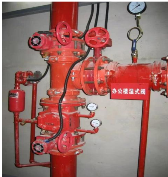
报警阀进出口设置的信号阀
