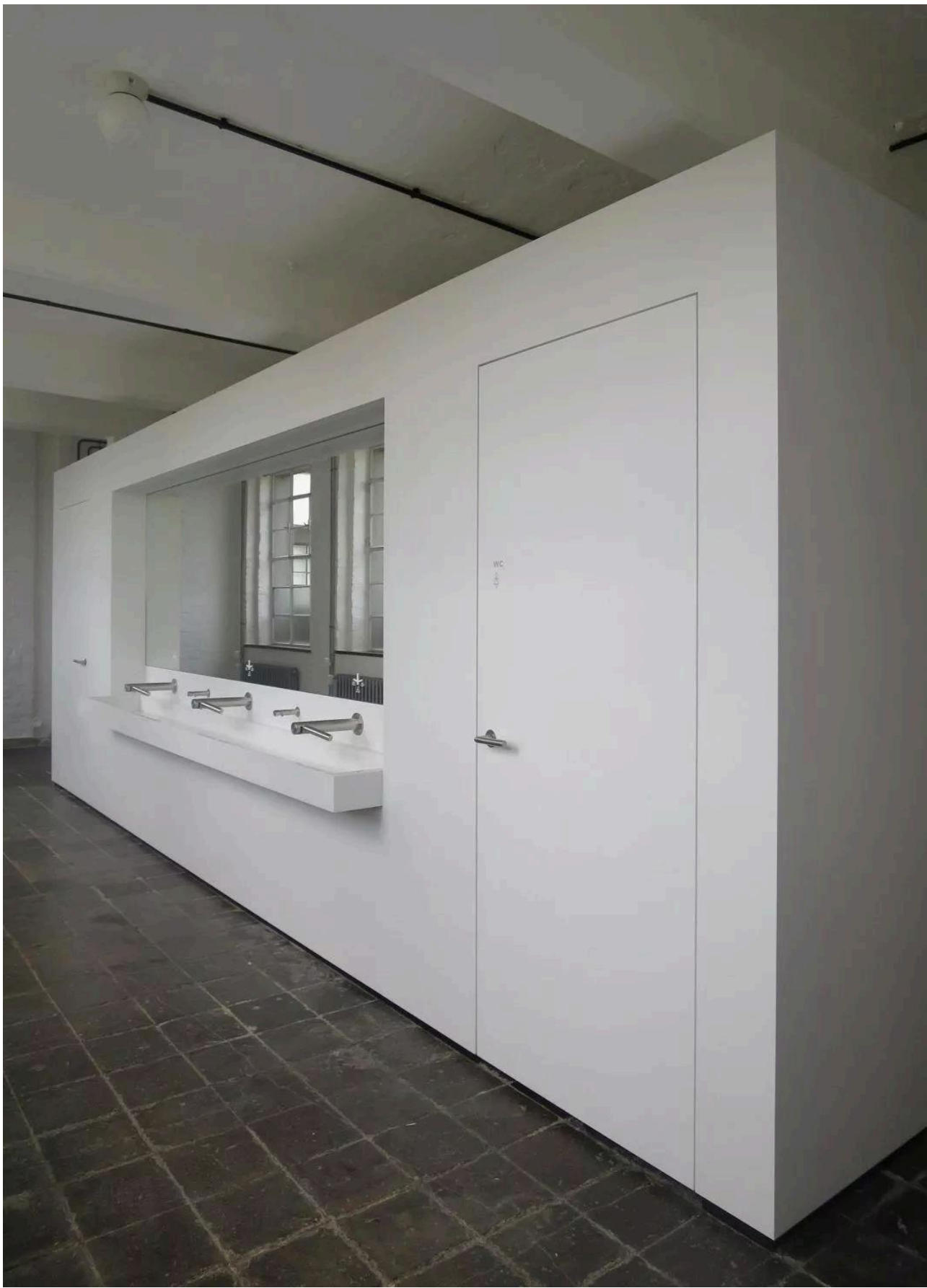
图/半地下室新“置入”的盥洗台，并不干扰原有结构体系 来源： https://www.brenne-architekten.de/bauhaus-dessau/
