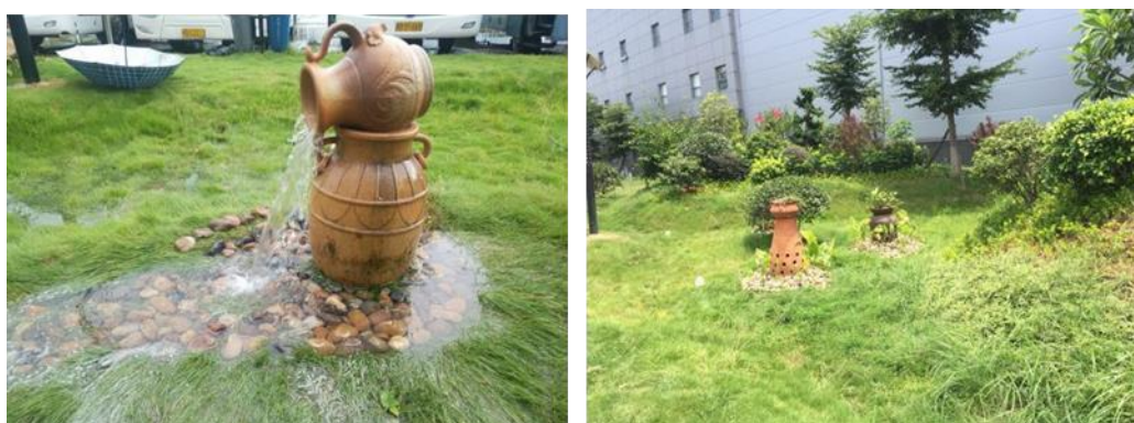
图 2 涌泉式出水口和雨水陶瓷灌溢流井
